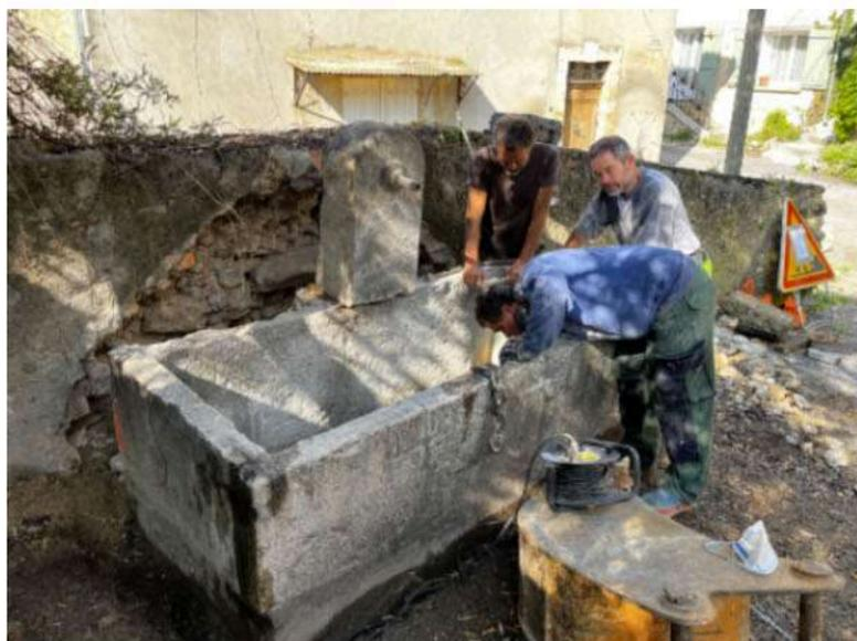
**Afin de consolider la voûte, les travaux ont du être fait à partir de l'extérieur. Pour cela, la fontaine de la placette du Portail a été descellée et déplacée. Le sol a été consolidé et la fontaine remise à sa place initiale.**
